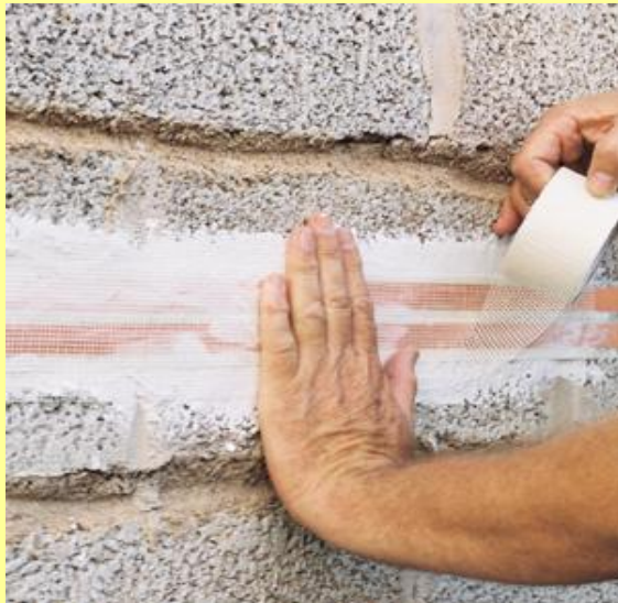
Aplicando tela de fibra de vidro para proteção
