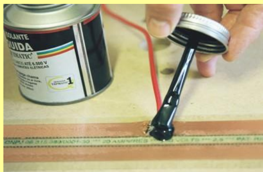
O isolamento da solda pode ser feito com Fita Isolante Líquida 'Quimatic'
