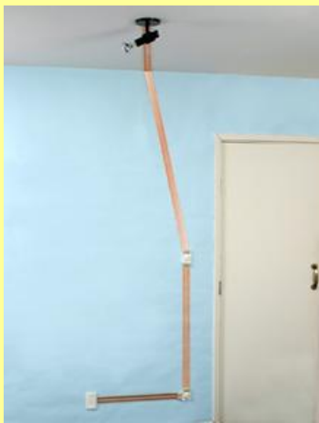
Instalação Pronta Faltando o acabamento
