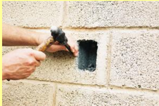
Abrindo bloco para embutir caixa 4x2
