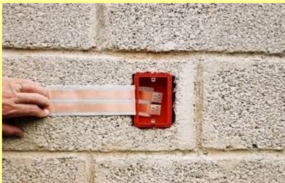
Colocando a caixa de embutir
