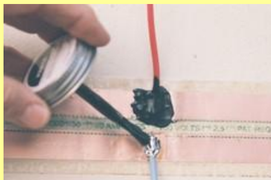
Isolamento com o produto já instalado
