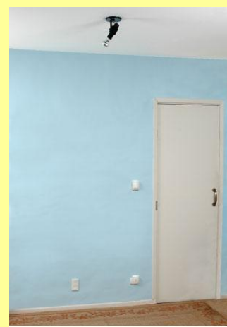
Situação final: Nova tomada e interruptor com luminária no teto
