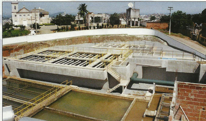
CEDAE está respondendo à pressão de privatização pela prefeitura com obras
