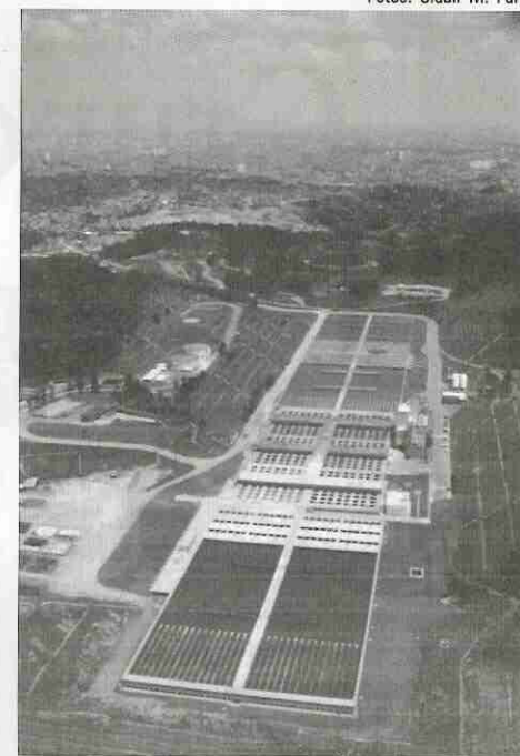
Estação de Tratamento de Água de Guaratuba.
